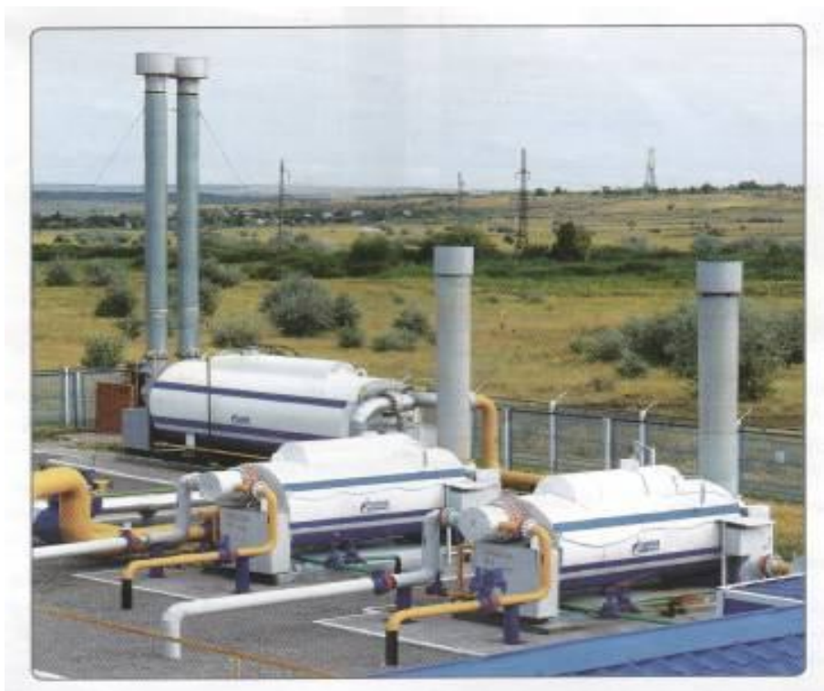
3.8-расм. ГРП одатда тақсимловчи тармоқларни газ билан таъминлайди
