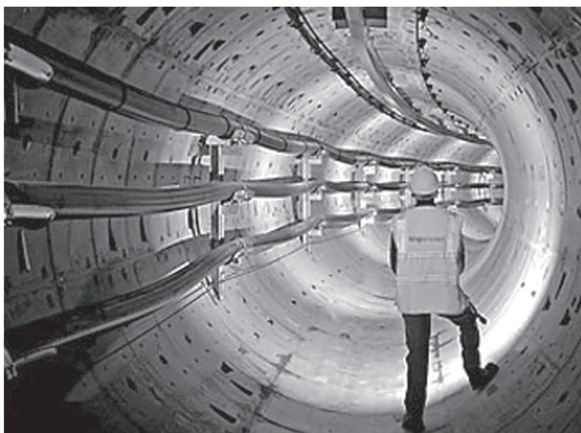
*Рис. 60.* Прокладка кабеля в тоннеле
