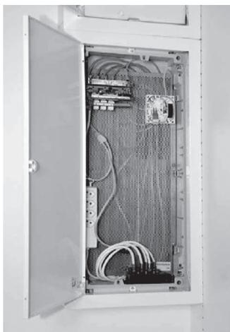
*Рис. 35.* Модуль ОТО, установленный в распределительный щит абонента
