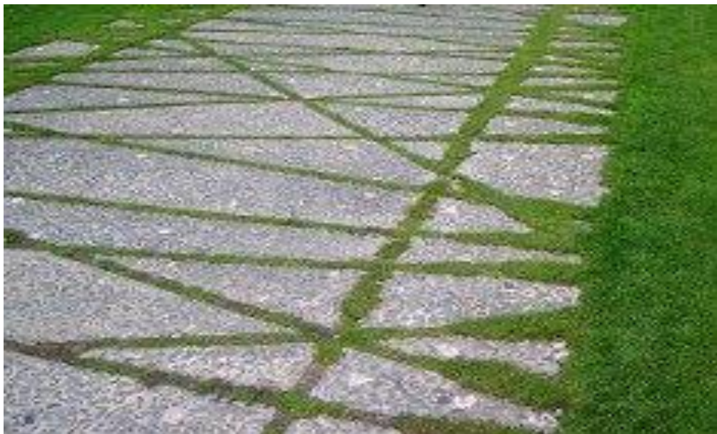
13–расм. Майсали шагал-бетон тўшама.
