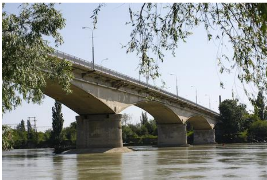
64-rasm. Katta temirbeton ko`prik.
