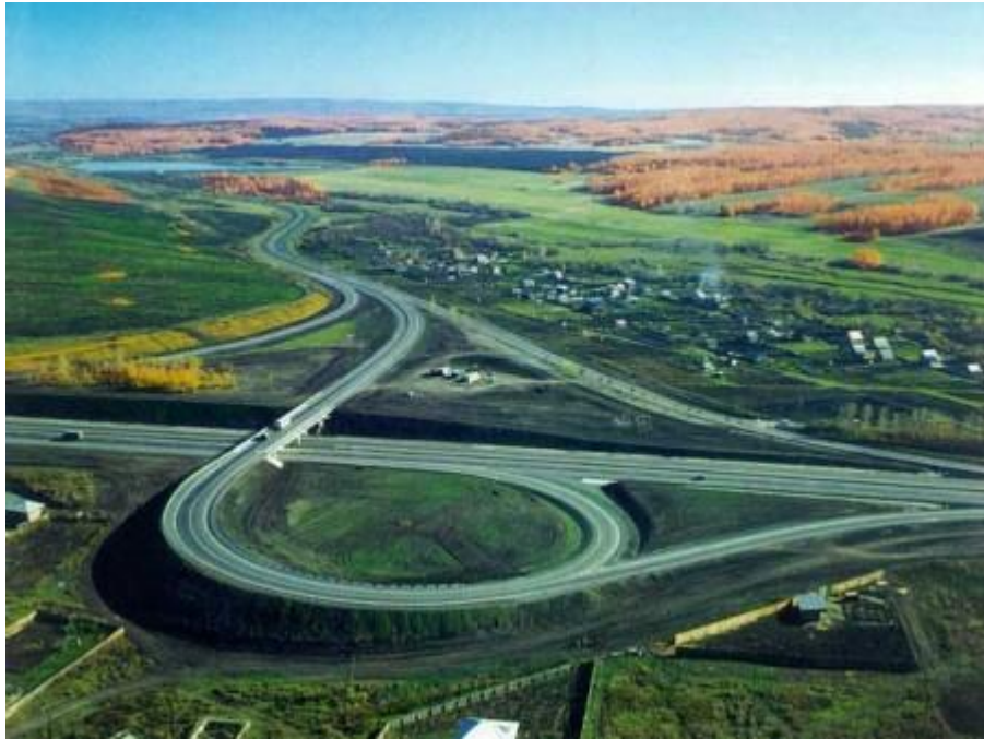
65-rasm. Avtomobil yo`llarini yo`l o`tkazgich asosida har satxdagi kesishishi.
