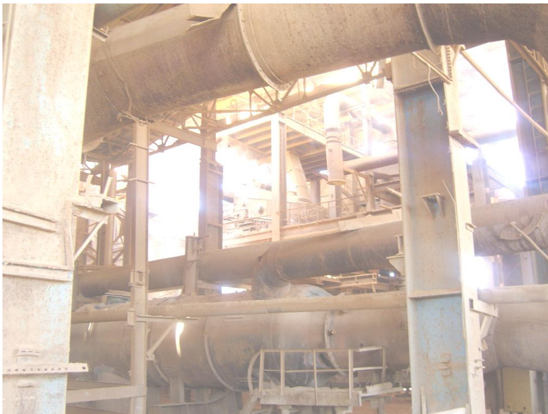
2.1-rasm. Samarqand kimyo kombinatining umumiy ko'rinishi
