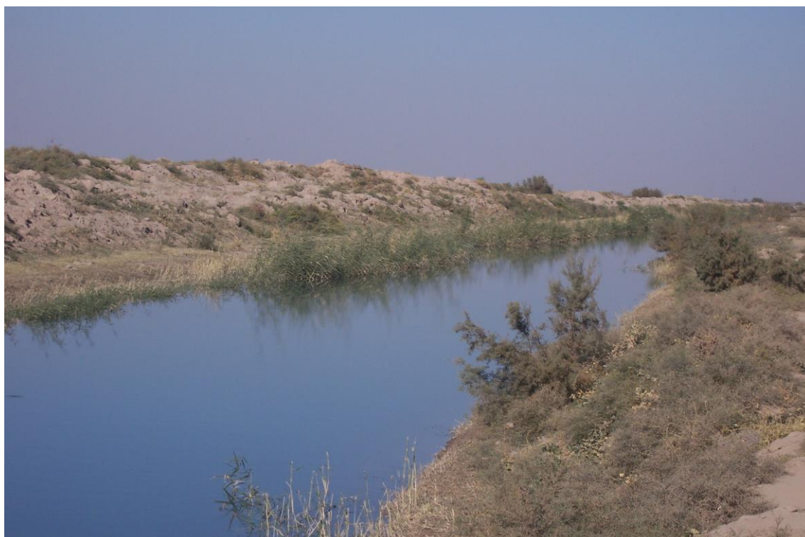
1.4-Rasm. Mirishkor kanalining PK 1140 dagi umumiy ko'rinishi
