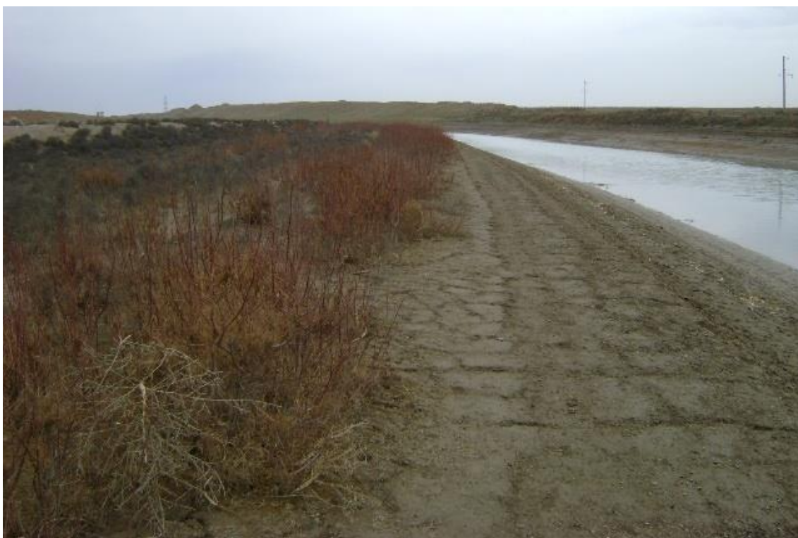
1.3-Rasm. Mirishkor kanalining PK 205 dagi umumiy ko'rinishi
