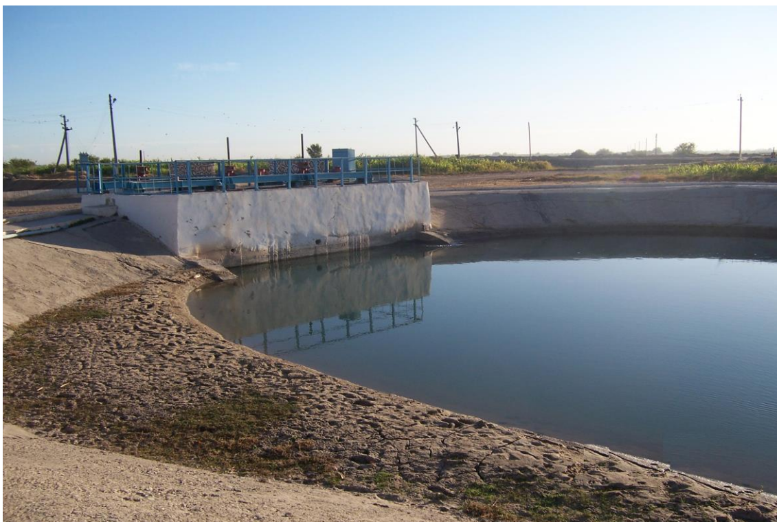
1.7-Rasm. Mirishkor kanalining PK933+00 dagi umumiy ko‘rinishi
