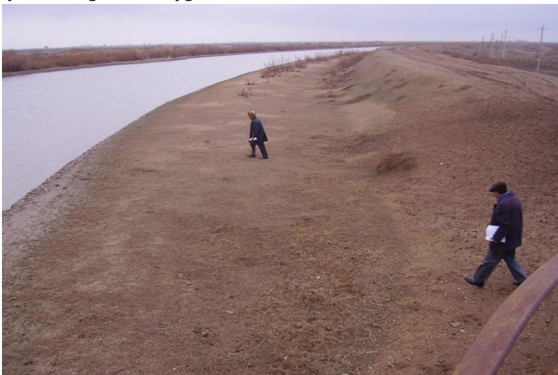
1.2-Rasm. Mirishkor kanalining PK 150 dagi umumiy ko'rinishi
