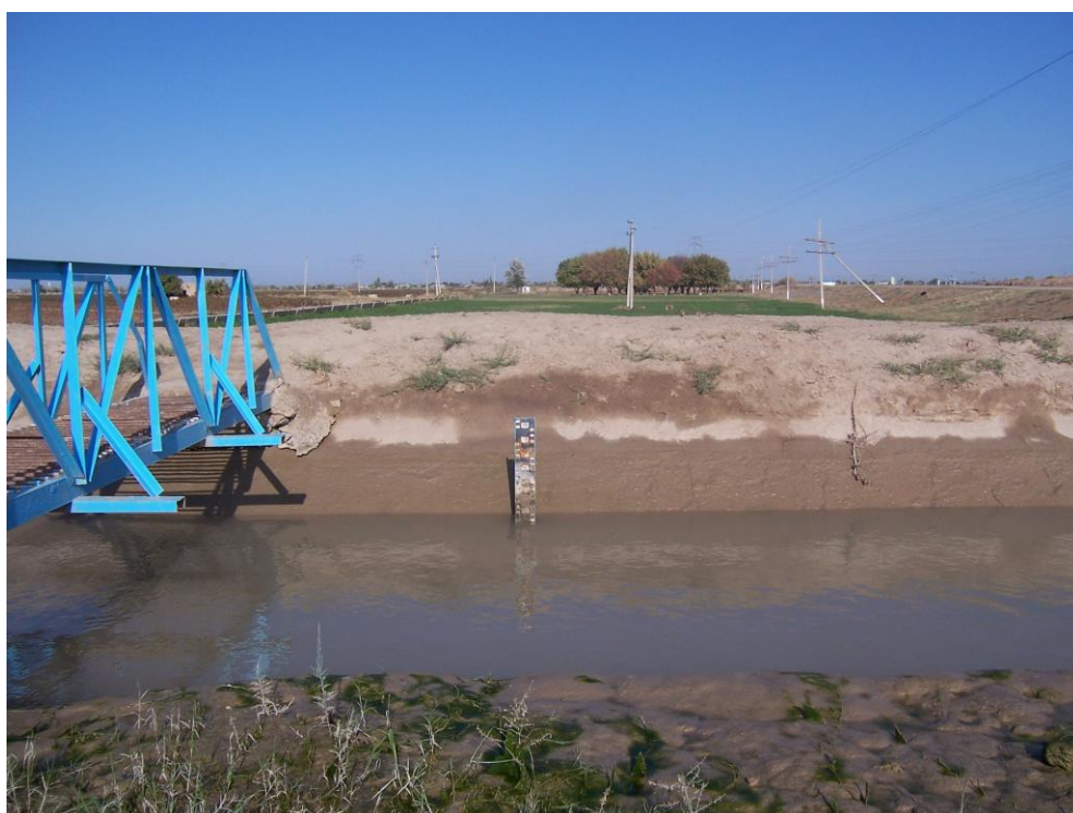
2.12-rasm. UR-5 kanalidagi gidrometrik reyka
