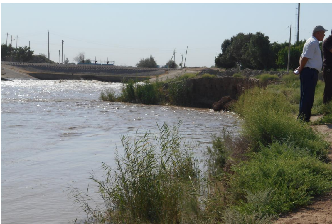
1.5-Rasm. Mirishkor kanalining PK793+72 dagi umumiy ko‘rinishi
