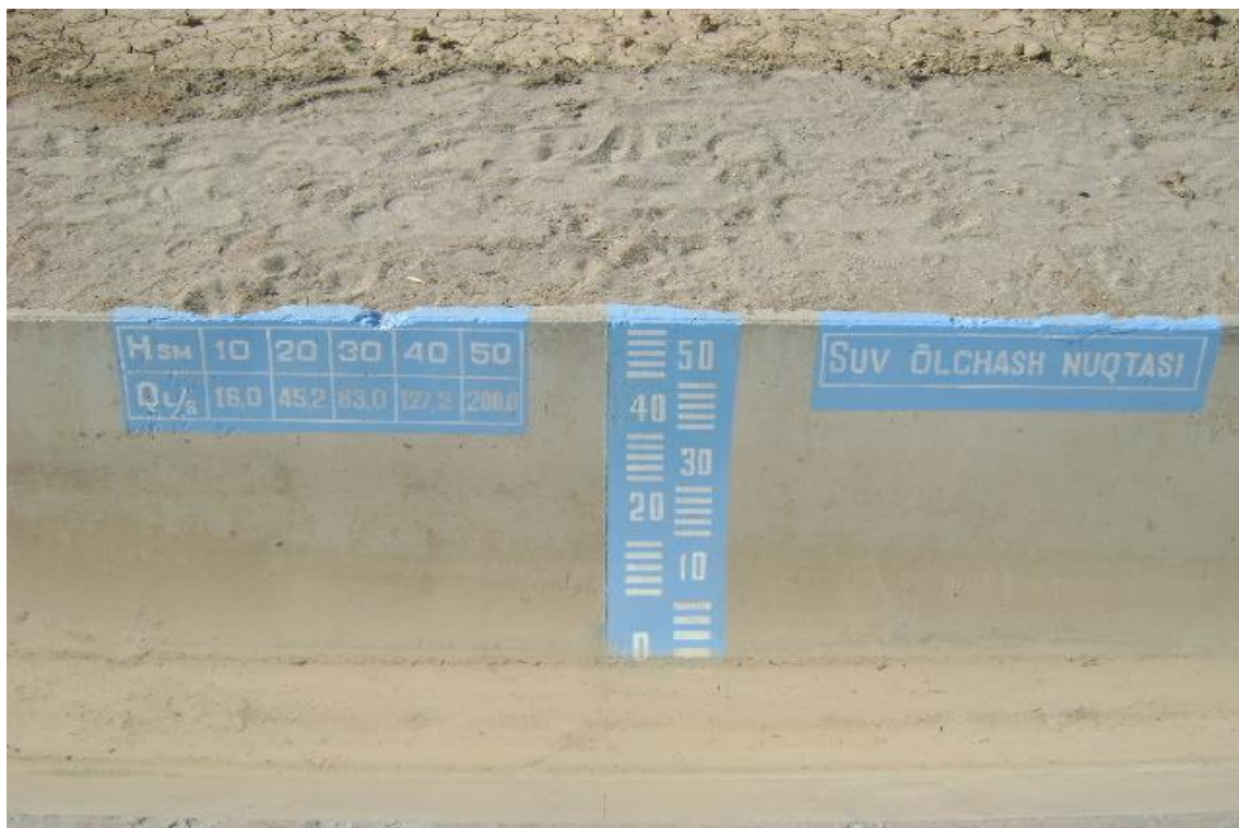
2.10-расм. Даражаланган параболик лоток.
