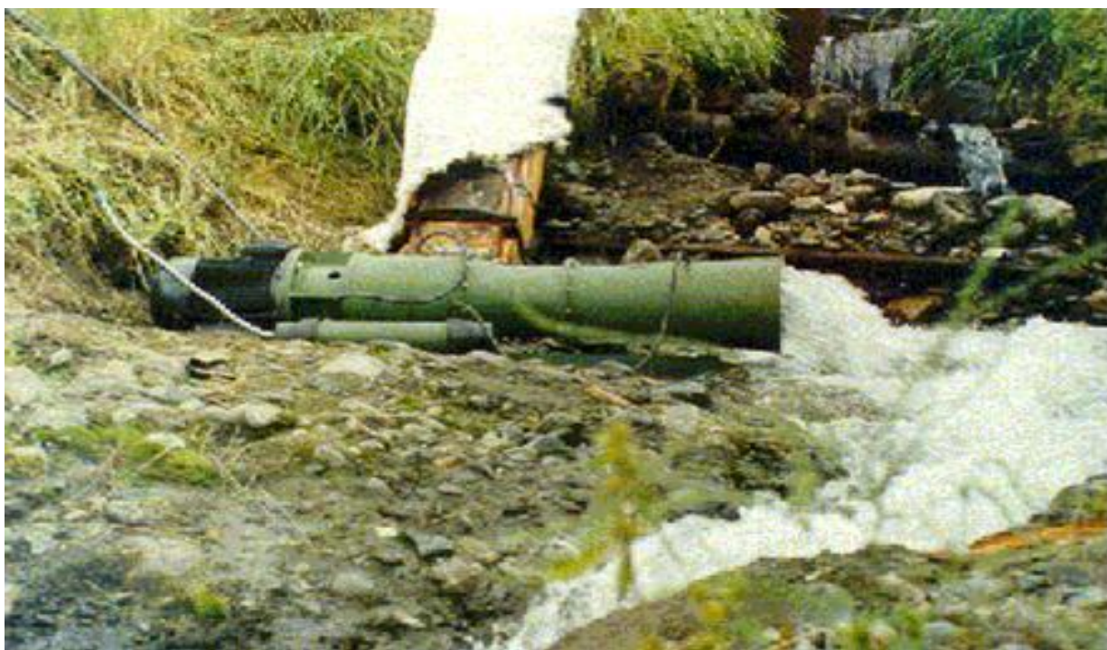
4.9 – rasm. Quvvati 10 kVt boʻlgan bosimli mikro GES ning umumiy koʻrinishi.
