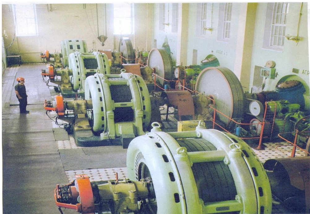
4.1 – rasm. O'zbekistonda eng birinchi qurilgan Bo'zsuv GES ning gidrogeneratorlar zali
