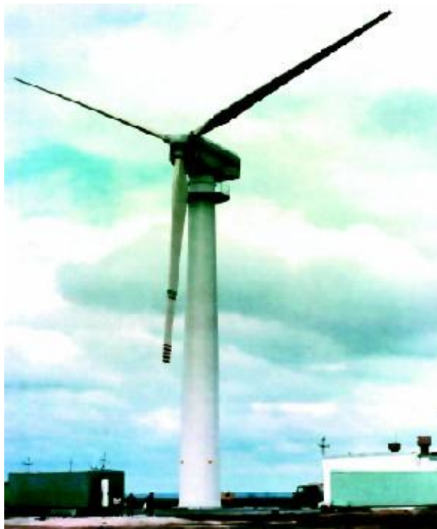
3.19 – rasm. Shamol elektr stansiyasining umumiy ko'rinishi
