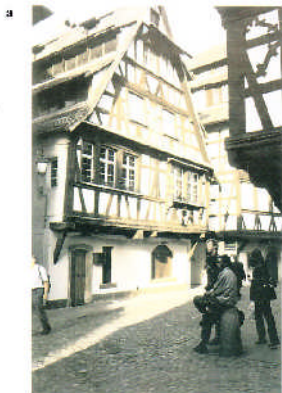
Рис. 6.16. Тектоника фахверковых и каркасных зданий: а – Страсбург. Фахверковый жилой дом ремесленника XVI в.; б – Берлин. Офис фирмы "Согей" со стальным каркасом. Арх. Х.Ян, 2000г.
