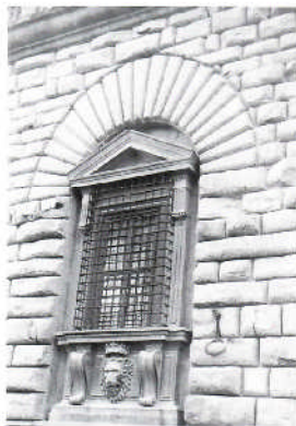
Рис. 6.17. Тектоника несущей каменной стены в архитектуре раннего Возрождения. Флоренция. Палаццо Строцци. Арх. Б. де Майано; Флоренция. Фрагмент фасада палаццо Питти. Арх. Ф.Брунеллески XV в.
