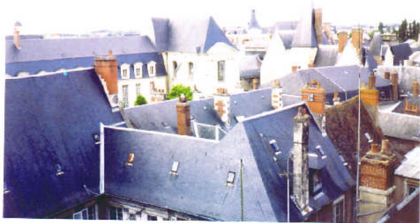
Рис. 20.1. Цвет и материал кровли в архитектурной композиции здания: 1 – Бюле, Франция. Здание монастырской больницы (цветная черепица); 2 – Бурж, (шипы естественного черного шифера)
