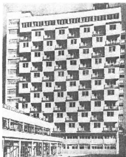
Рис. 11.8. Выявление стетковичности несущих наружных стен: а — шахматным чередованием панелей стен и лоджий по высоте; б — то же лоджий и солнцезащитных решеток
