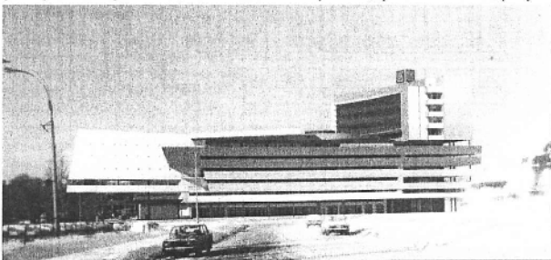
Рис. 26.13. Проект многоэтажного гаража – стоянки на ул. Б. Екатерининская (Москва). Арх. Г. П. Надточий и др.
