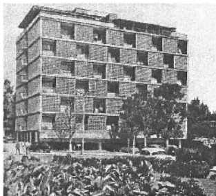
Рис. 11.8. Выявление стетковичности несущих наружных стен: а — шахматным чередованием панелей стен и лоджий по высоте; б — то же лоджий и солнцезащитных решеток
