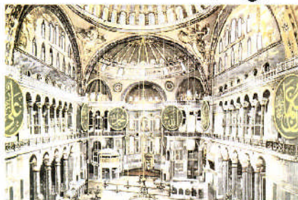
Рис.5.12. Стамбул. Собор Св. Софии (VI в. н.э.): а – общий вид, б – план; в – аксонометрия несущих конструкций; г – интерьер; 1 – арочные устои, воспринимающие распор покрытия в поперечном направлении; 2 – парус; 3 – купол; 4 – шлюккупла, воспринимающие распор в продольном направлении
