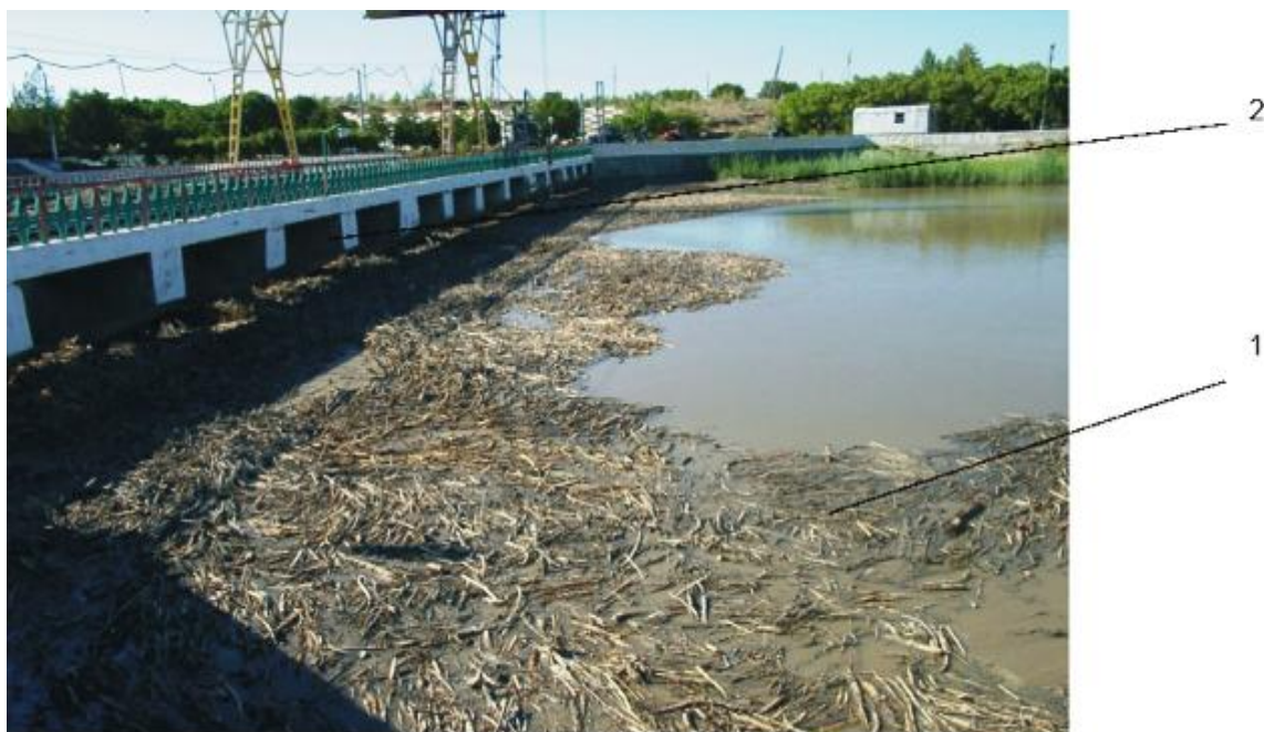
Расм-1. Ҳамза -2 насос станциясида оқизикларни панжара олдида тўпланиши.
