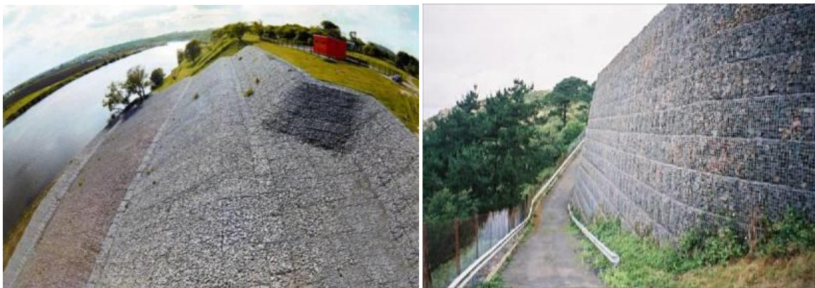
1.10-расм. Габион конструкциялари ёрдамида қияликларни мустаҳкамлаш
