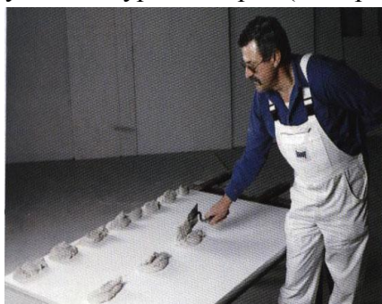
10.5-расм. Ёпиштириладиган гипс картон юзага елим жойлаш.
