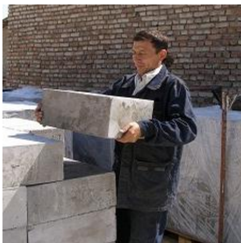
12.7-расм. Ўзбекистон “Хориж қурилиш” компаниясида ишлаб чиқарилаётган деворбоп енгил кўпикбетон блок
