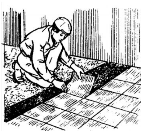
81-rasm. Plitkalarni sovuq mastikada yopishtirish
