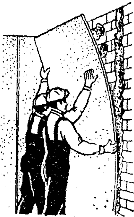
48-rasm. Devorlarni gips qoplama listlar bilan qoplash
