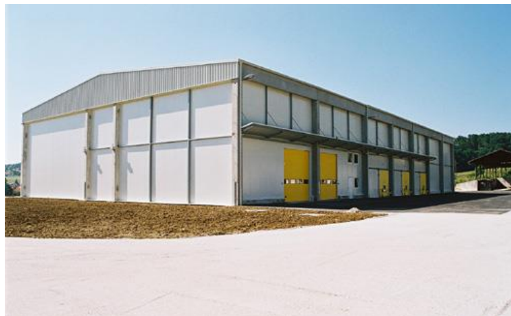
1-rasm. Vaqtincha to'kib qo'yish, saralash, quritish uchun bostirma va maydonchaga ega bo'lgan zamonaviy sabzavot ombori
