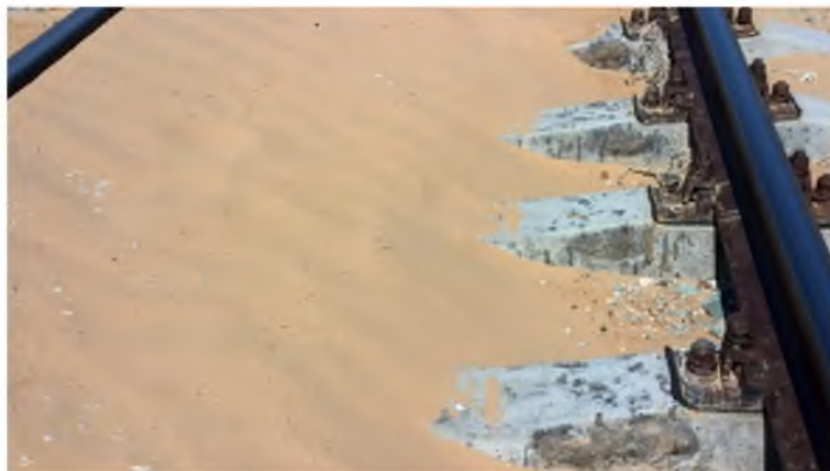
Рис. 1. Сильнозаносимые участки железной дороги на перегоне Учкудук – Бузаубай участок ПК 273 + 50 ÷ ПК 273 + 90: а, в – вторая категория заносимости межрельсового пространства; б – первая категория
