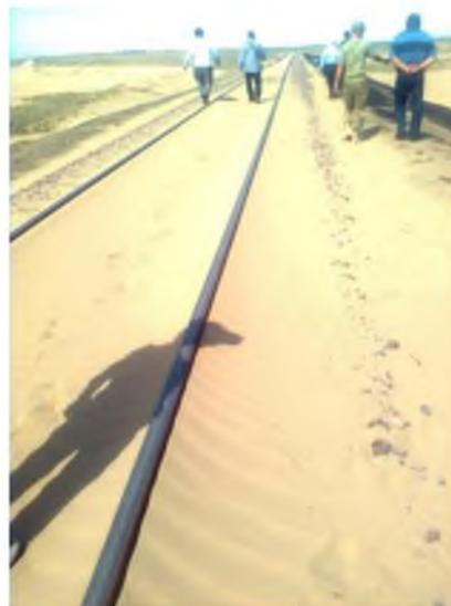
Фото 7, 8 Основная площадка и откосы земляного полотна после проведения ПДПД укрепления от развевания, где не полностью учтены физико-механические свойства грунтов слагающих откосы полотна, погодноклиматические и гидрометеорологические и другие факторы
