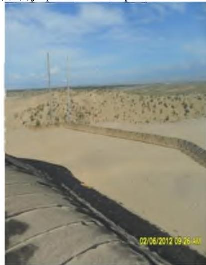
Фото 4 Основная площадка и откосы земляного полотна после проведения комплексного ПДПД укрепления от развевания
