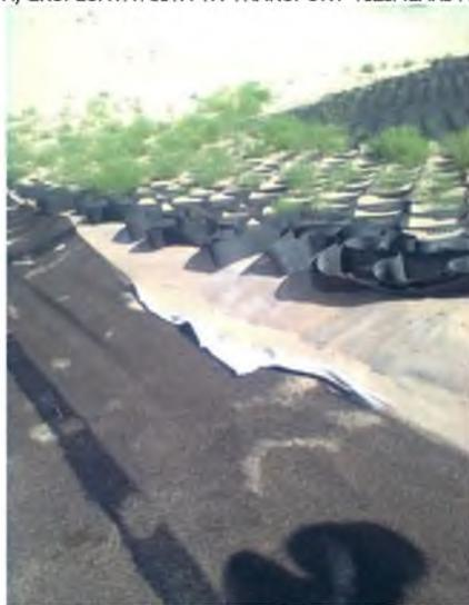
Фото 5 Основная площадка и откосы земляного полотна после проведения ПДПД укрепления от развевания (появление первичных результатов проведенных работ)
