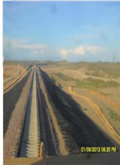
Фото 2 Основная площадка и откосы земляного полотна после проведения ПДПД укрепления от развевания
