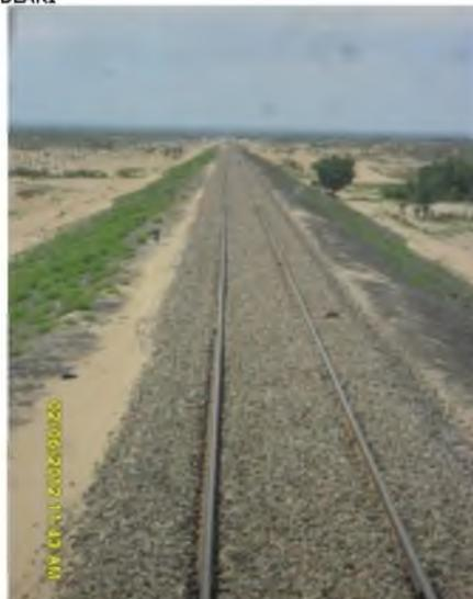
Фото 6 Основная площадка и откосы земляного полотна после проведения ПДПД укрепления от развевания (эффект от проведенных работ, 6 месяцев спустя)
