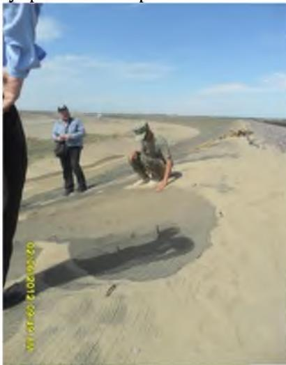
Фото 3 Основная площадка и откосы земляного полотна после появления локальных деформаций
