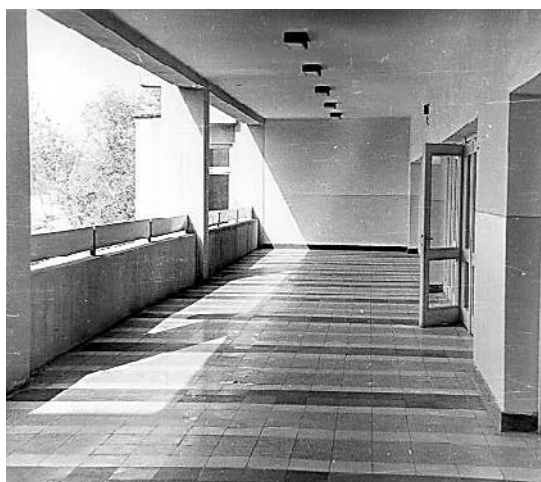
Рис. 158. Примеры солнцезащитных устройств в зданиях и сооружениях. А - сплошная солнцезащита на галереи административного здания; Б - коробчатая система на здании правительства в Чандигархе (Индия); В – матерчатое солнцезащитное устройство (зарубежный опыт); Г - галерея и открытая рекреация, используемая в качестве солнцезащиты (Школа им. Димитрова в Ташкенте).
