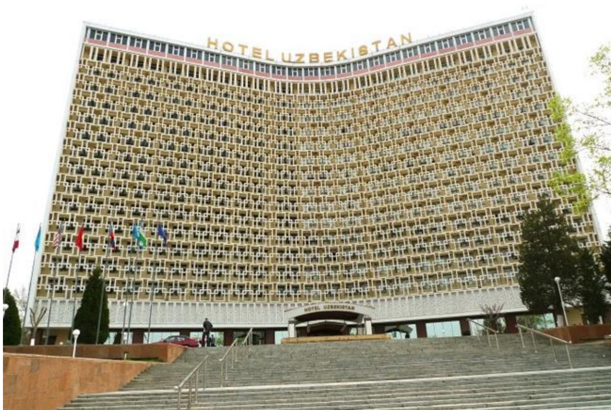
Suratda: “O‘zbekiston” mehmonxonasi
