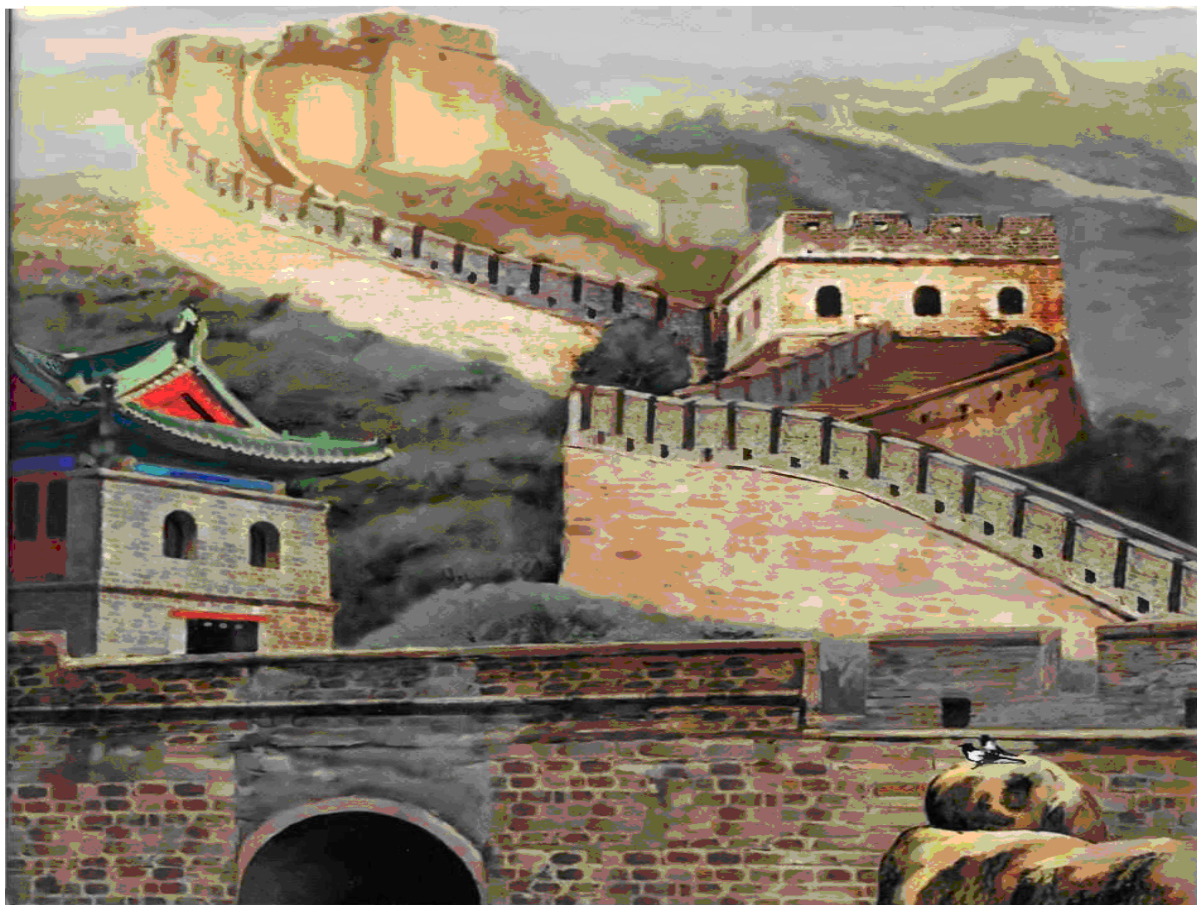
Рис. 61. Строительство Великой Китайской стены в Циньской империей.
