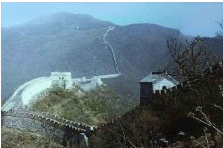
Рис. 79. Труднодоступные участки стены.
