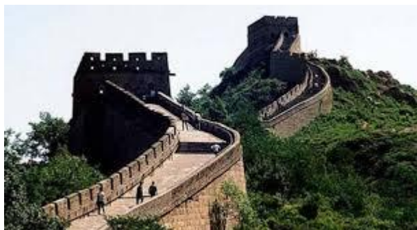
Рис. 70. Строительство Великой стены в лесистой зоне.
