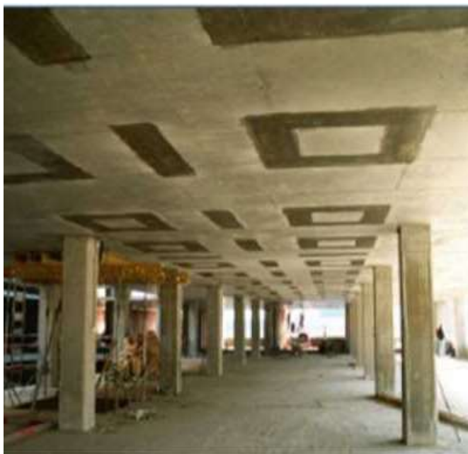
1-расм–темирбетон ораёлма (а) ва устунни (б) фиброарматураланган пластиклар билан кучайтириш
