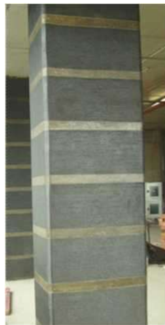
1-расм–темирбетон ораёлма (а) ва устунни (б) фиброарматураланган пластиклар билан кучайтириш
