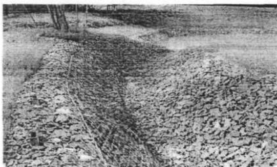
1-rasm. Gabion matras konstruksiyali kanal o'zani
