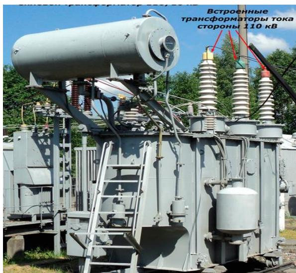
**Рис. 2. Силовой трансформатор напряжения 110/10 кВ**
