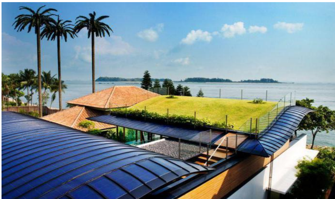
Рис. 2. Экстенсивная зеленая кровля
