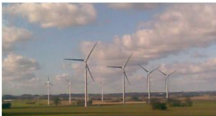
2.2-rasm. SHamol generator qurilmasi va elektrostansiyasi
