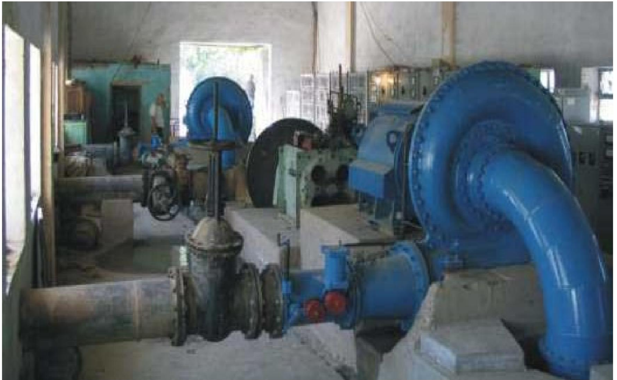
12.8-rasm. Gorizontaal radial-o'qiy turbinalar o'rnatilgan kichik GES binosining ko'rinishi.
