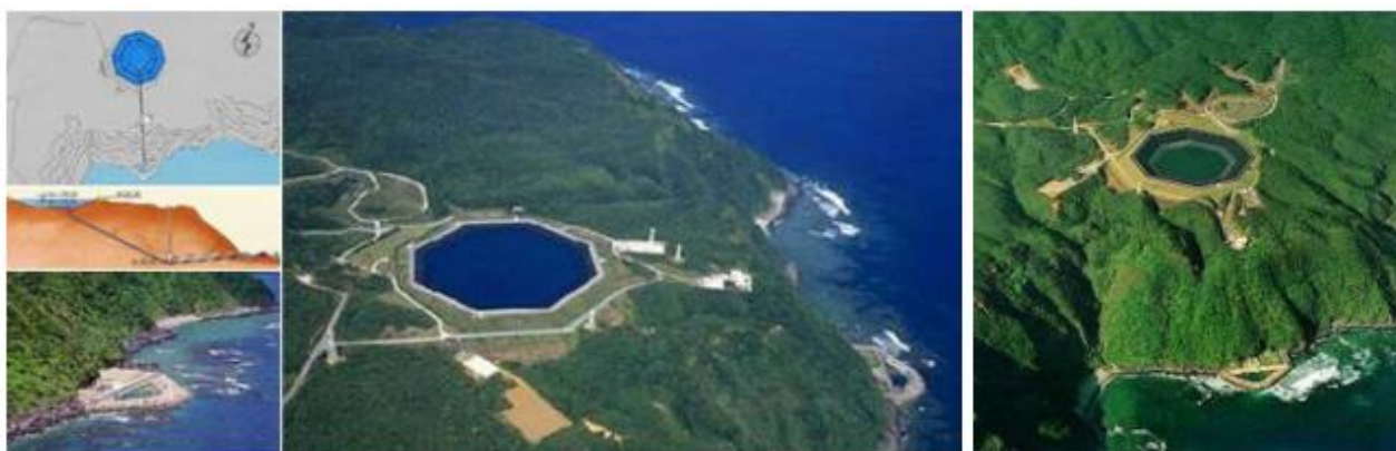
16.9-rasm. Dengizdan yuqorida joylashgan hajmning suvga to‘ldirilishi va suvni qayta tashlab elektroenergiya olish.
