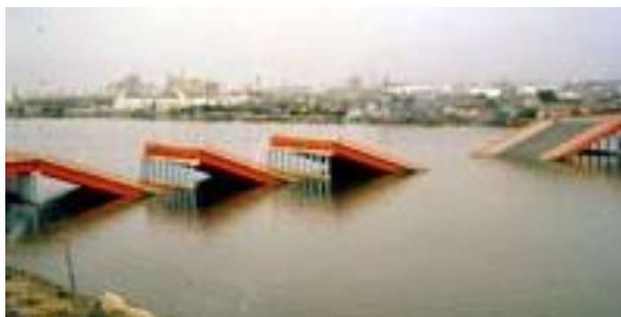
14–расм. Шова-Огаши кўпригини бузилиши (Ниигата, 16 июн, 1964 й.)
