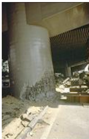
15–расм. Таянчларни шикастланиши (Тайван, 1999 й.)
