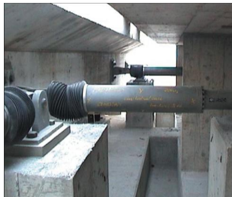
28-расм. Мегалорема (Греция) даги ёпишқоқ демпферли виадук
