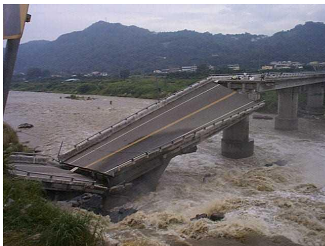
16-расм. Зилзила пайтида оралиқ қурилмаларнинг қулаши ва таянчларнинг шикастланишлари (Тайвань, 1999 й.)
