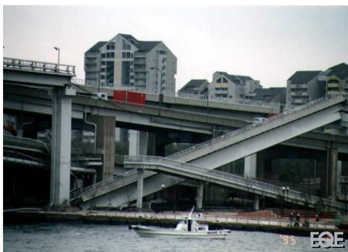
8–расм. Кобадаги (Япония, 1996й.) транспорт иншоотлари туташмаси оралиқ қурилмаларини қулаши
