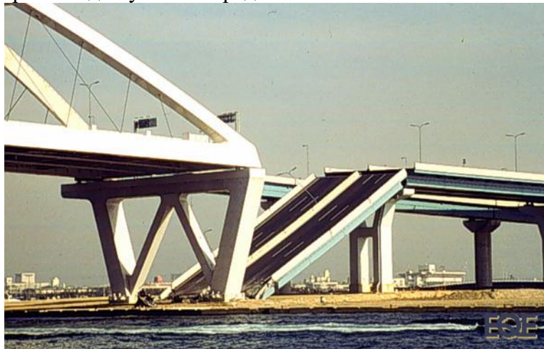
7–расм. Кобадаги (Япония, 1996й.) зилзила вақтида автомобил йўллари кўпригининг оралиқ қурилмаларини қулаши
