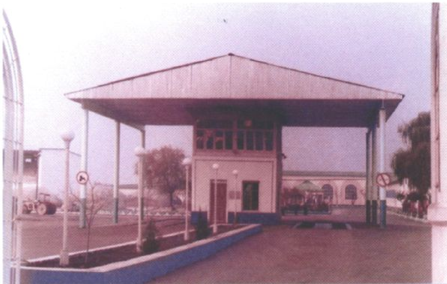
2.2-rasm. Chigitli paxtani qabul qilishda, uning vaznini aniqlash uchun qullaniladigan ekki tomonli torozixona
