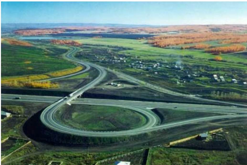
65-rasm. Avtomobil yo'llarini yo'l o'tkazgich asosida har satxdagi kesishishi.
