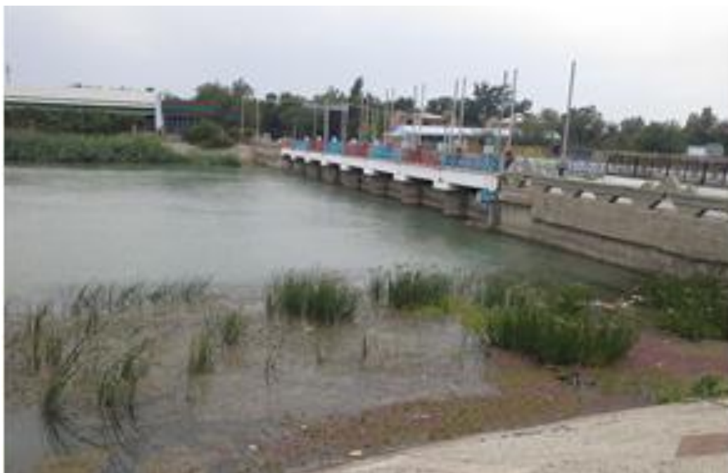
5.13 - расм. Жанубий Мирзачўл каналининг ПК 145 даги гидроузелни пастки бьефи ўзанида ўсган сув ўтлари
