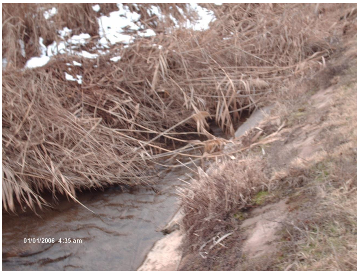
5.16 - расм. Бетон каналлар четини ўт босиши
