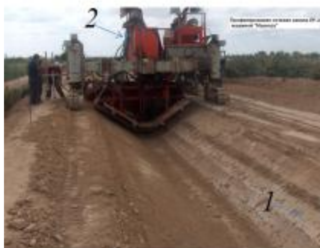
2.7 - расм. Канал ўзанини бетонлашга тайёрлаш:
