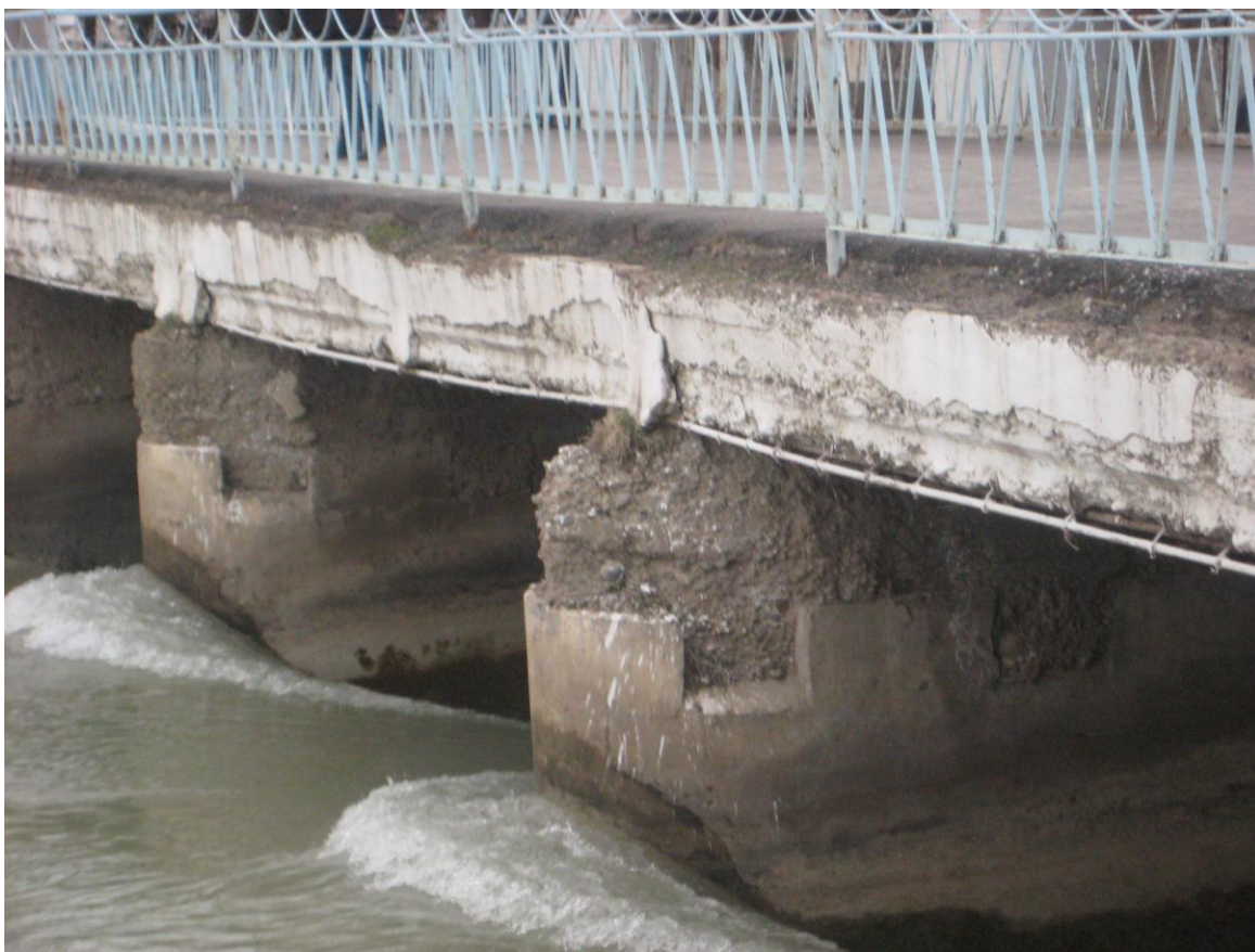
5.6 - расм. Дўстлик канали ПК 460 да жойлашган гидроузел оралиқ устунларининг емирилиш ҳолати
