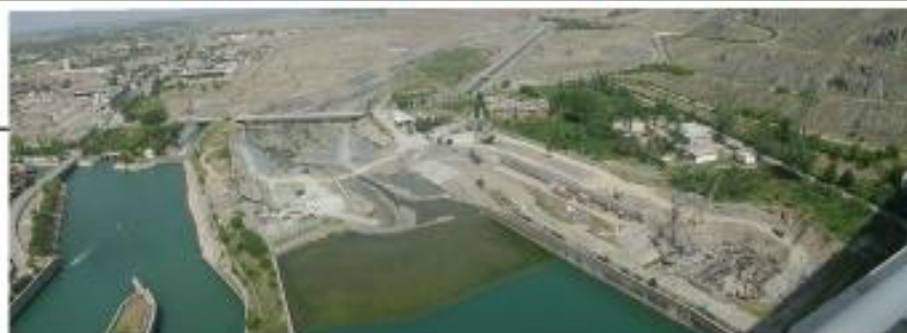
Фото 1. Строительство малой ГЭС: котлован под здание ГЭС, отводящий канал с выпуском в р. Карадарья, дюкер под р. Карадарья с подключением к каналу Шарикансай.
