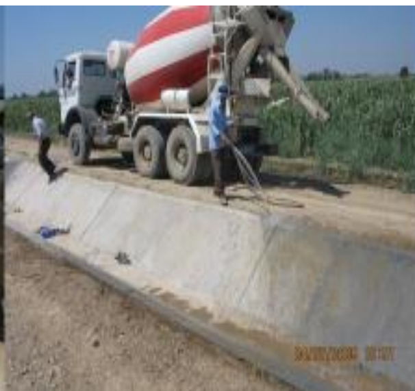
2.10 - расм. Қуйилган бетонга техник қаров ишларини амалга ошириш
