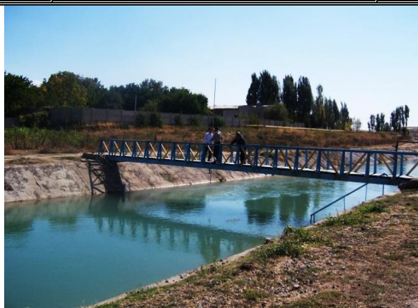
1.2 - расм. Ўзгармас ўзан типидagi гидропост.
