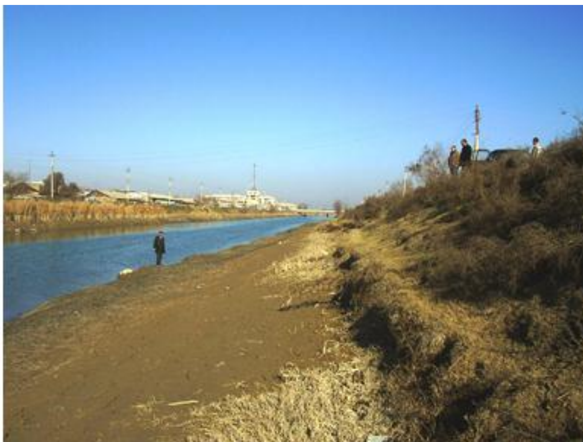
5.18 - расм. Дўстлик каналининг қабариқ қисмидаги лойқа чўкиш ҳолати
