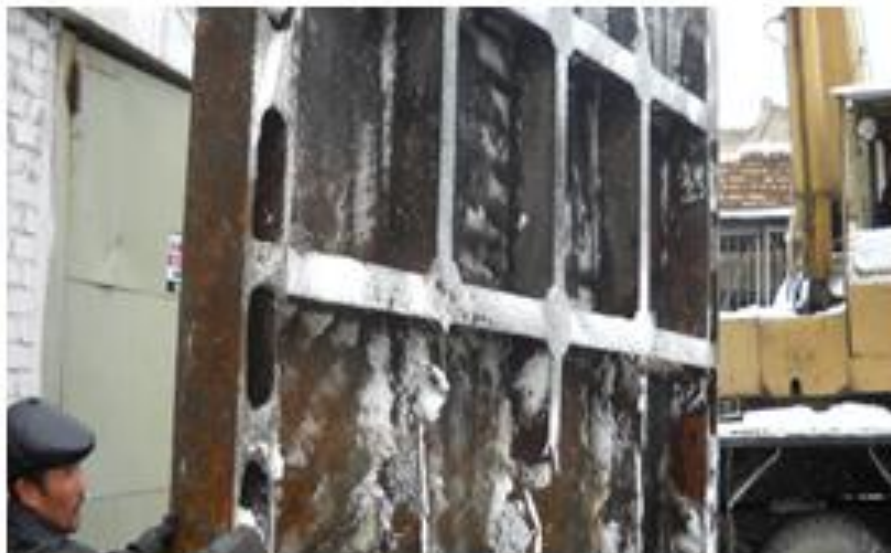
5.4 - расм. Дўстлик каналини ПК 260 ва ПК 580 да жойлашган гидроузелларга ўрнатилган затворларда юз берган каррозия ходисаси
