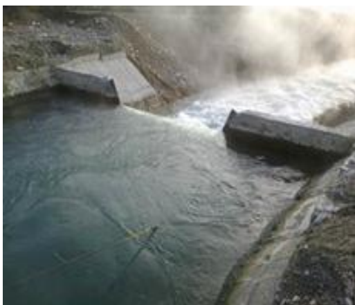
1.11 - расм. Сув сарфи 10 \text{ м}^3/\text{с} га яқин бўлгандаги ўтказгичлардан фойдаланиш жараёни.
