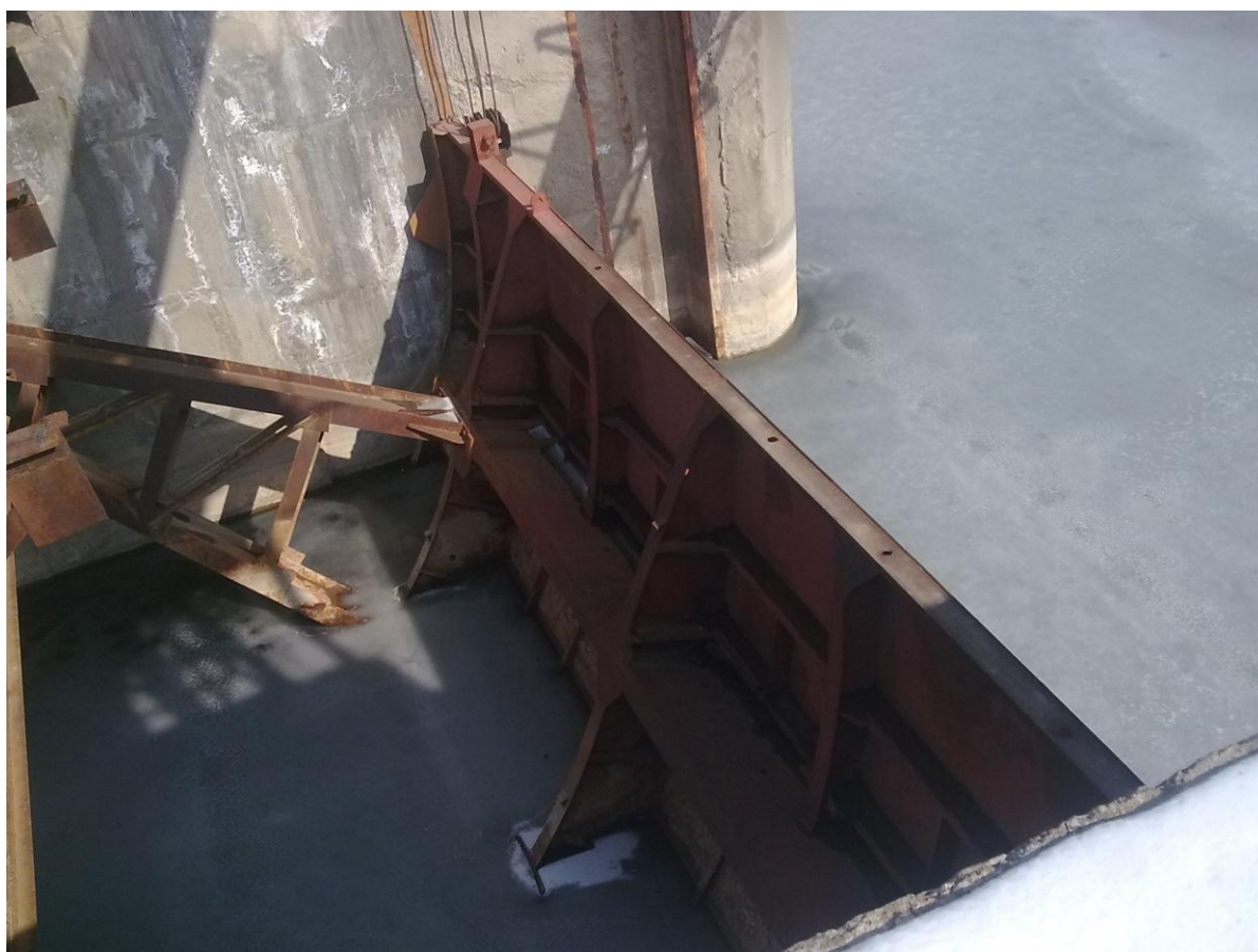
5.7 - расм. Гидроузелдаги сувнинг музлаш ҳолати
