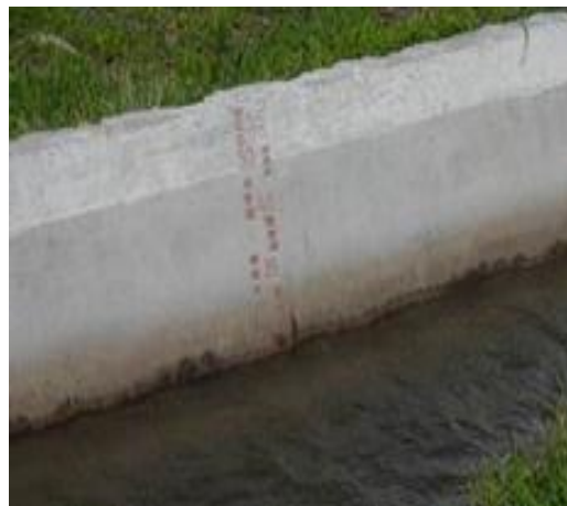
1.10 - расм. Стандарт параболик нов.
