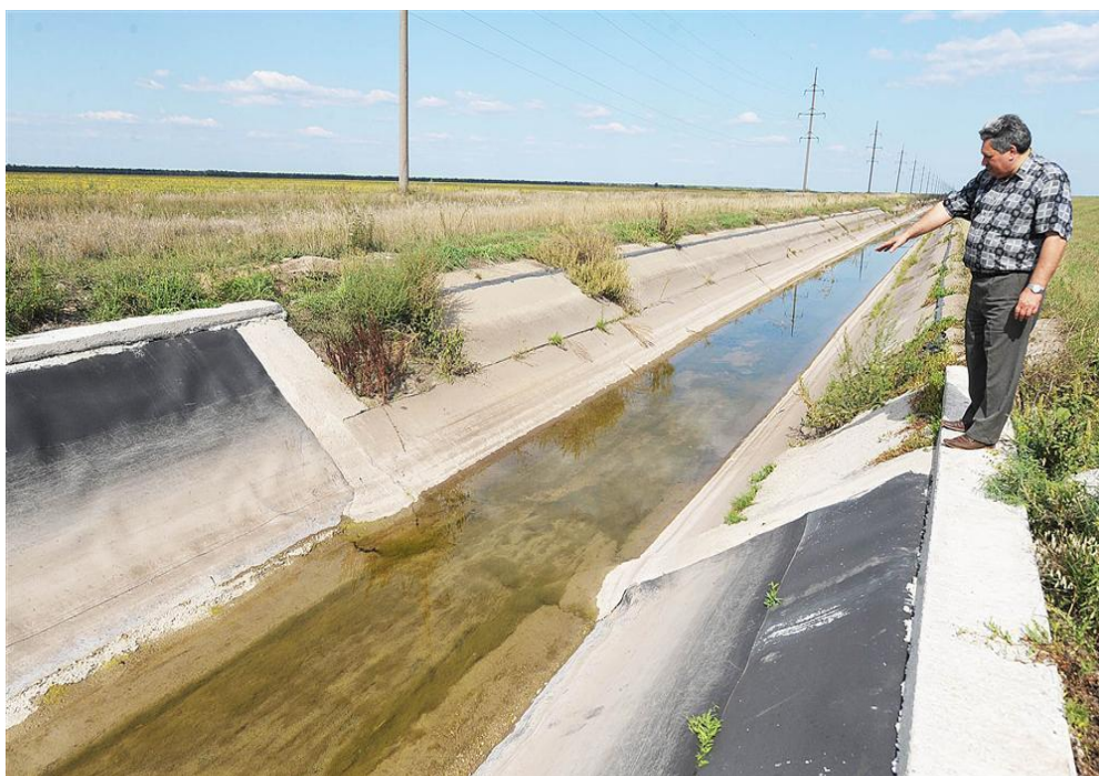
5.10 - расм. Канал ўзанида ўсган сув ўтларни фойдо бўлиши
