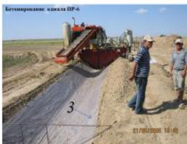
2.7 - расм. Канал ўзанини бетонлашга тайёрлаш:
