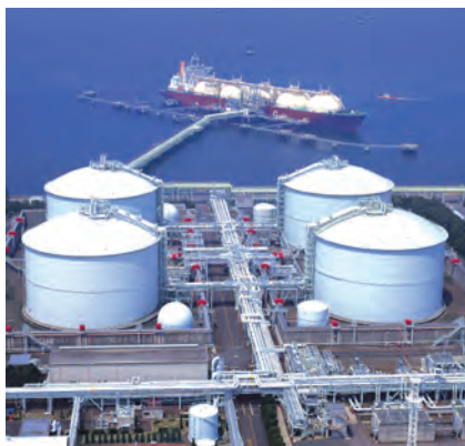
16-rasm. Suyultirilgan tabiiy gazni saqlovchi rezervuarlar.
