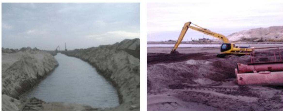
Рис. 15. Работы по сооружению трещин при бесплотинном водозаборе из Амударьи в КМК.
