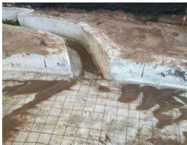
Рис. 9. Накопление наносов при бесплотинном водозаборе во времени
