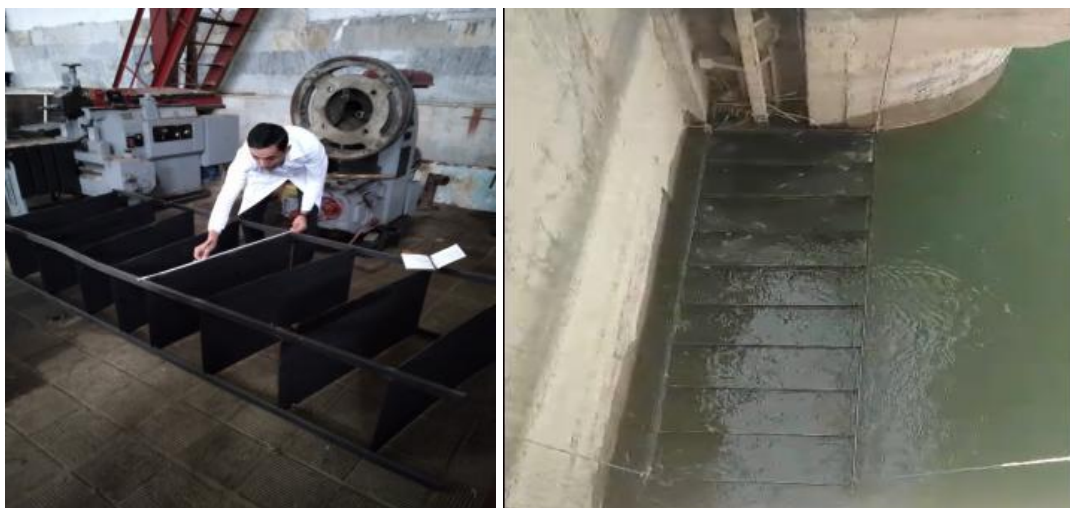
Рисунок 8. Процесс подготовки устройства для устранения водяных сгустков, образующихся в аванк-камере, и его состояние, установленное в аванкамере.
