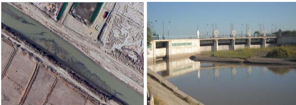
Рисунок 1. Заиление и размыв магистрального канала Анасай
