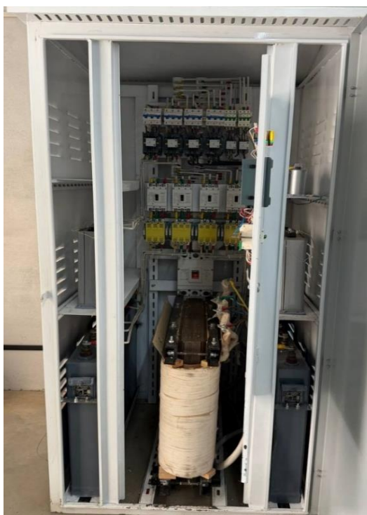
6-rasm. 5 va 7-garmonikaga sozlangan passiv filtr-kompensatsiya qurilmasi
