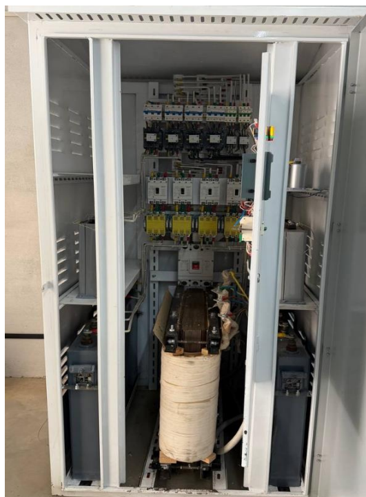
Рис. 6. Пассивное фильтро-компенсирующее устройство, настроенное на 5-ю и 7-ю гармоники
