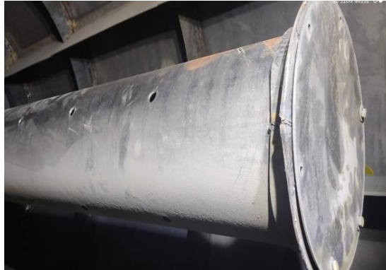
9-rasm. Quritish agentining bir qismini, taxminan 30-40 % ini quvur orqali radial kiritib berishni amalga oshirish maqsadida tayyorlangan quvurli moslamalarni o'rnatilgandagi ko'rinishi
