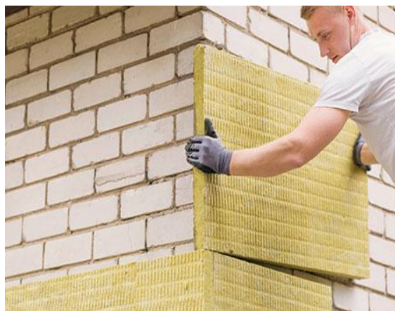
5.8-rasm. Mineral paxta yoki penopoliuretandan iborat tovush yutuvchi qatlamlar qo‘shilgan ko‘p qatlamli devorlar.
