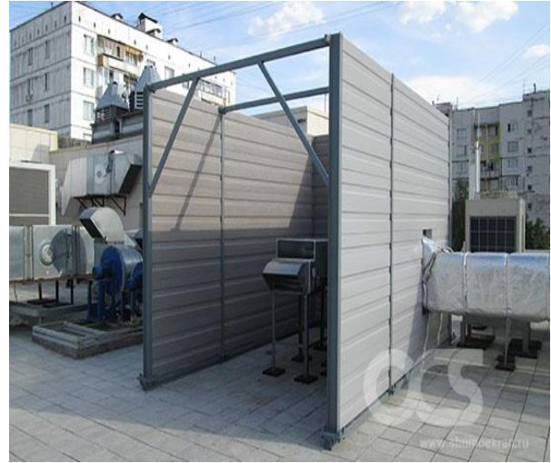
5.16- rasm. Chillerning shovqin yutuvchi ekranlari
