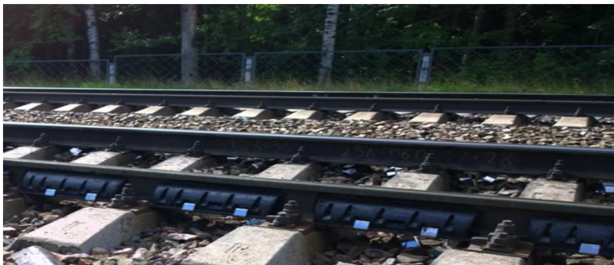
5.13- rasm. Rels bo‘yniga o‘rnatilgan vibrodempfirlovchi qoplamalarning umumiy ko‘rinishi
