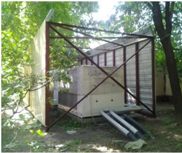
5.16- rasm. Chillerning shovqin yutuvchi ekranlari
