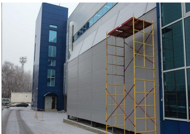
5.15- rasm. Konditsionerlash tizimlari tashqi bloklarining shovqindan himoyalovchi to'siqlari
