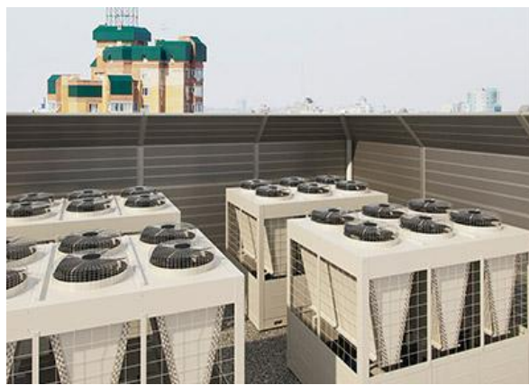
5.15- rasm. Konditsionerlash tizimlari tashqi bloklarining shovqindan himoyalovchi to'siqlari
