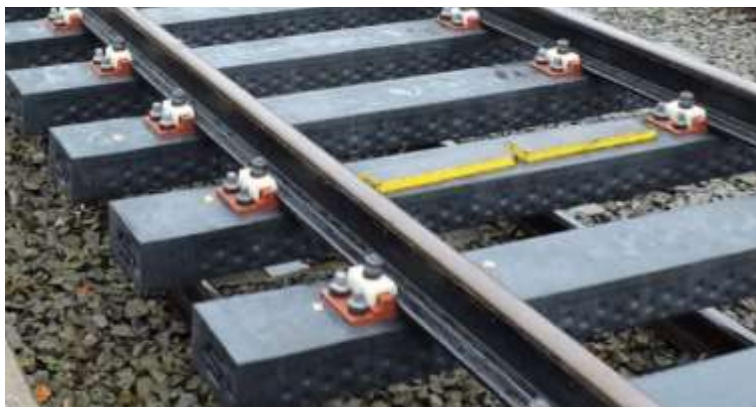
10-rasm. Kompozit temir yo'l shpallari
