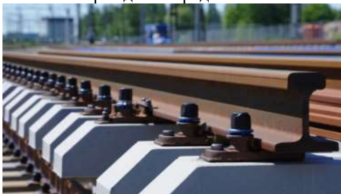
Рисунок 8. Железобетонные шпалы
