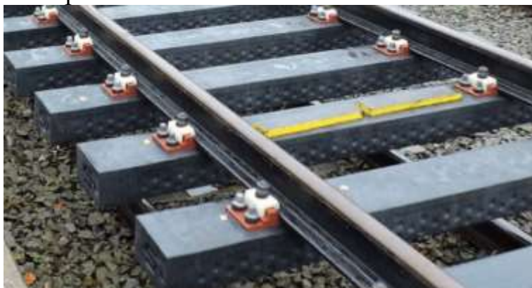
Рисунок 10. Композитные железнодорожные шпалы
