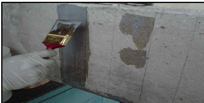
4.15-rasm. Belgilangan joyga epoksidli smolani suvash
