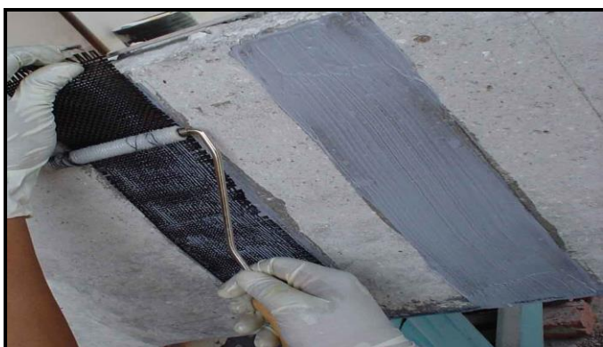
4.16-rasm. Tolaning yo'riqnomasiga muvofiq qirrali rolikni qo'llash
