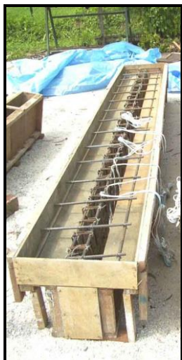
4.4-rasm. Tavr shaklli to'sinlarni yog'och qoliplarda tayyorlash
