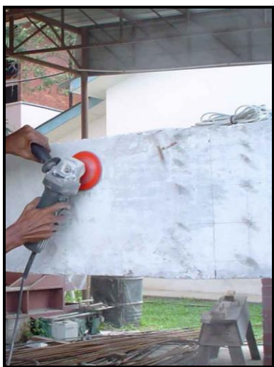
4.13-rasm. Betonli to'sin yuzasini mexanik maydalagich yordamida tayyorlash
