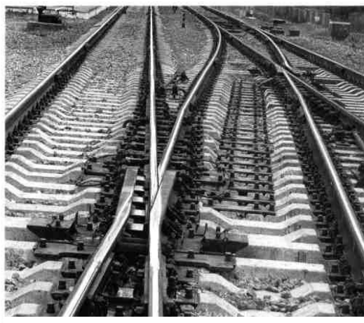
1.7 – расм. P65 типдаги 1/11 маркали стрелкали ўтказгичда узлуксиз юзали юмалоқланган крестовина
