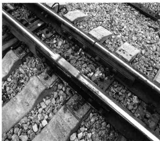
1.6 – расм. Юқори пишиқликдаги накладка ва пайванд билан изоляциаланган тугаш жой
