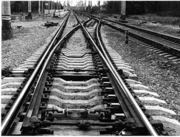
1.10 – расм. Р65 туридаги ва 1/11 маркали юқори тезликдаги ҳаракат учун стрелкали ўтказгич
