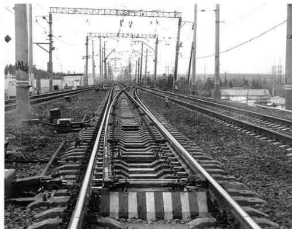
1.9 – расм. Р65 туридаги ва 1/22 маркали тез ҳаракат учун стрелкали ўтказгич
