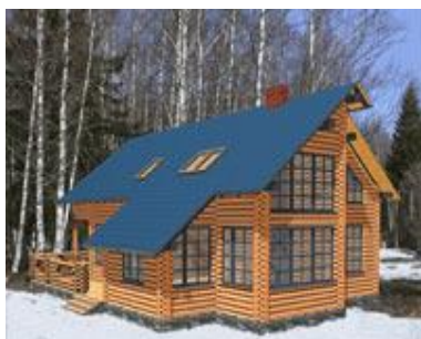
Қалинлиги 0,4-1,2 мм ли рухланган, полимер бўёқ билан бўялган профнастил билан ёпилган том.
