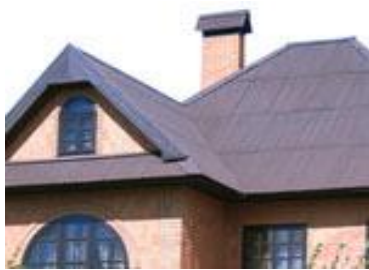
Целлюлоза толали, қалинлиги 2-3 мм ли матони махсус битум билан шимдириб бўялган томбоп тўлқинли битум листи.
