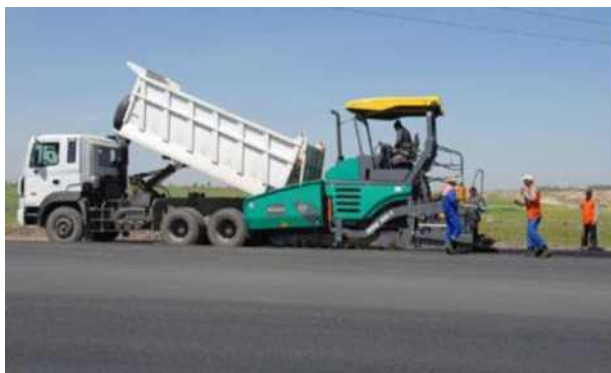
71-расм. Иссик асфальтобетон коришмасини йўлга ёткизиш технологик жараёнида лавхалар.
