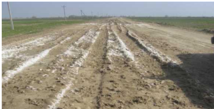
54- расм Шурхоқ грунтдан кутарилган йўл пойи юзасини қуриши
