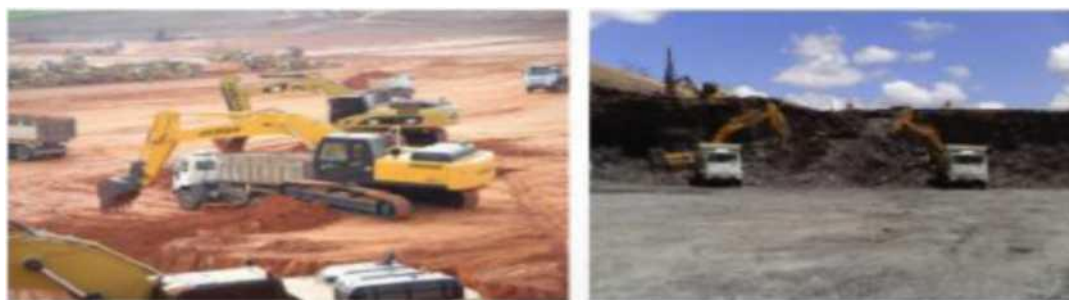
39-расм: Грунтни резервда экскаватор билан казиб автосамосвалга ортиш
