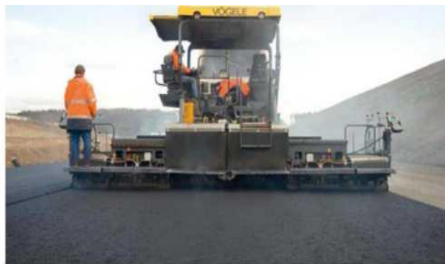
71-расм. Иссик асфальтобетон коришмасини йўлга ёткизиш технологик жараёнида лавхалар.
