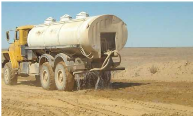
13- расм. Грунт намлигини оптимал кийматга етказиш учун сув сепиш жараёни.
