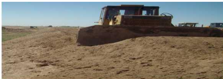
31- расм Ташиб келтирилган грунтни ёйиб текислаш
