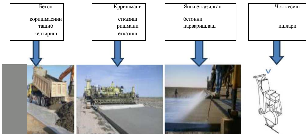
78- расм: цементбетон қопламаларини қуриш технологией жараёнини ишлаш кетма кетлиги.
