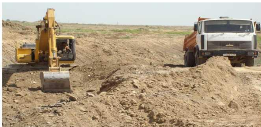
38-расм Грунтни резервда экскаватор билан казиб автосамосвалга ортиш
