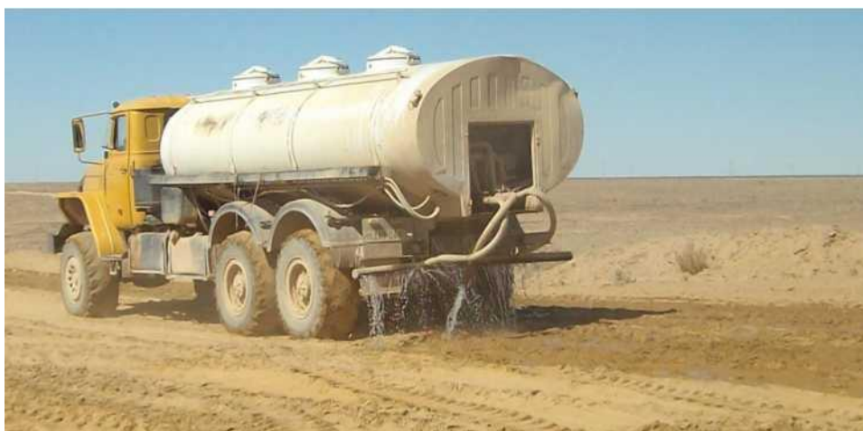
44- расм. Грунт намлигини оптимал кийматга етказиш учун сув сепиш жараёни.
