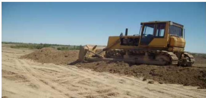
30-расм. Ўймадан кўтармага грунтни бульдозер ёрдамида кесиб суриш.
