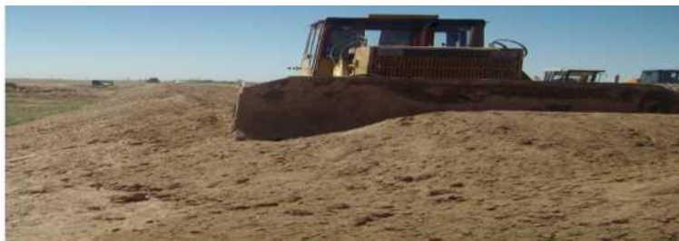
31- расм Ташиб келтирилган грунтни ёйиб текислаш
