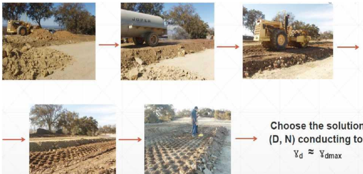
16- расм қовурғали каток билан грунтларни зичлаш кетма кетлиги.
