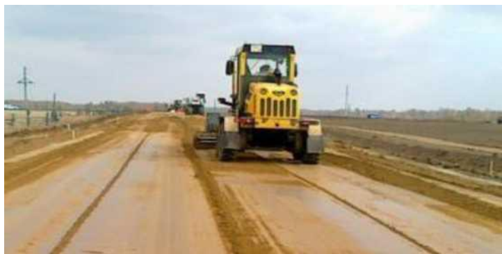
56- расм Йўл пойи юзасини автогрейдер билан пардозлаш
