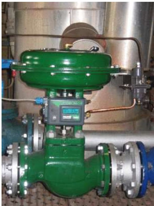
9.29-rasm. Rostlanadigan klapanidagi membranali pnevmatik yuritma
