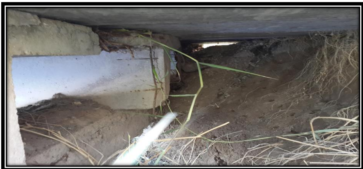
1.3- rasm. Tayanchni umumiy ko'rinishi oraliq qurilma balkasiga o'rnatilgan o'tuvchi plita
