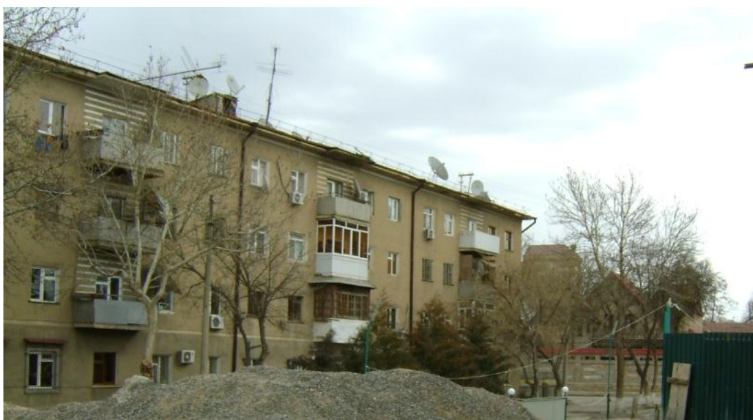
Фото.3.2.1. Фасад типового 4-х этажного по конструкции железобетонного дома по ул. Курчатова, в г.Самарканде.
