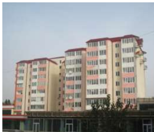
Яхлит темир бетонли
