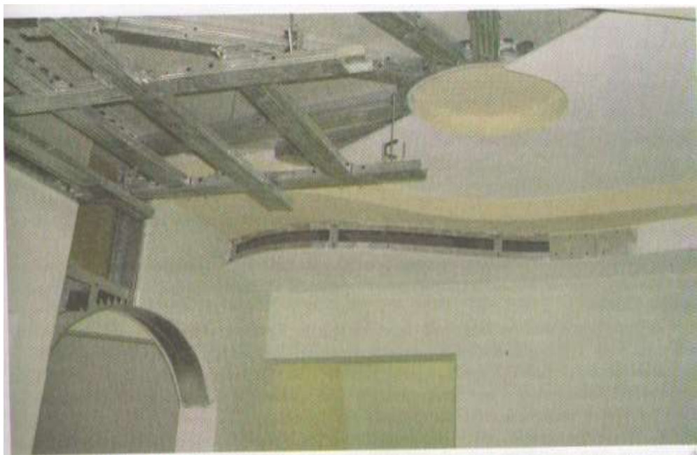
3.20-расм. Хона шифтига металл каркас ва гипскартон листларни ўрнатиш
