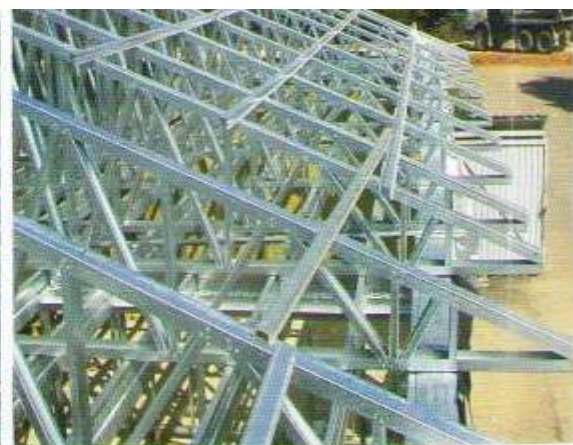
Том фермаси конструкцияси
