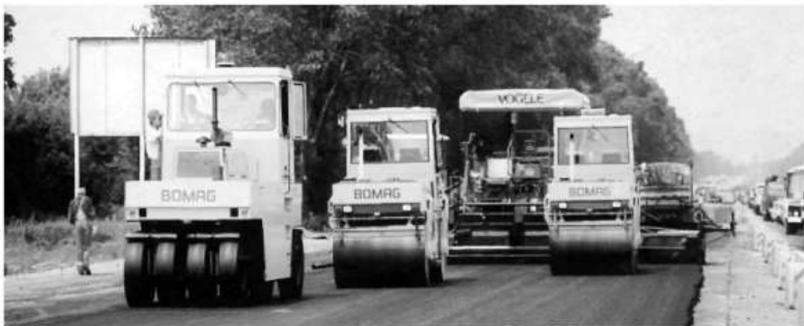
7.4-расм. Йўл қопламасига ётқизилган асфальтбетон қоришмасини ҳар ҳил катокларда зичлаш
