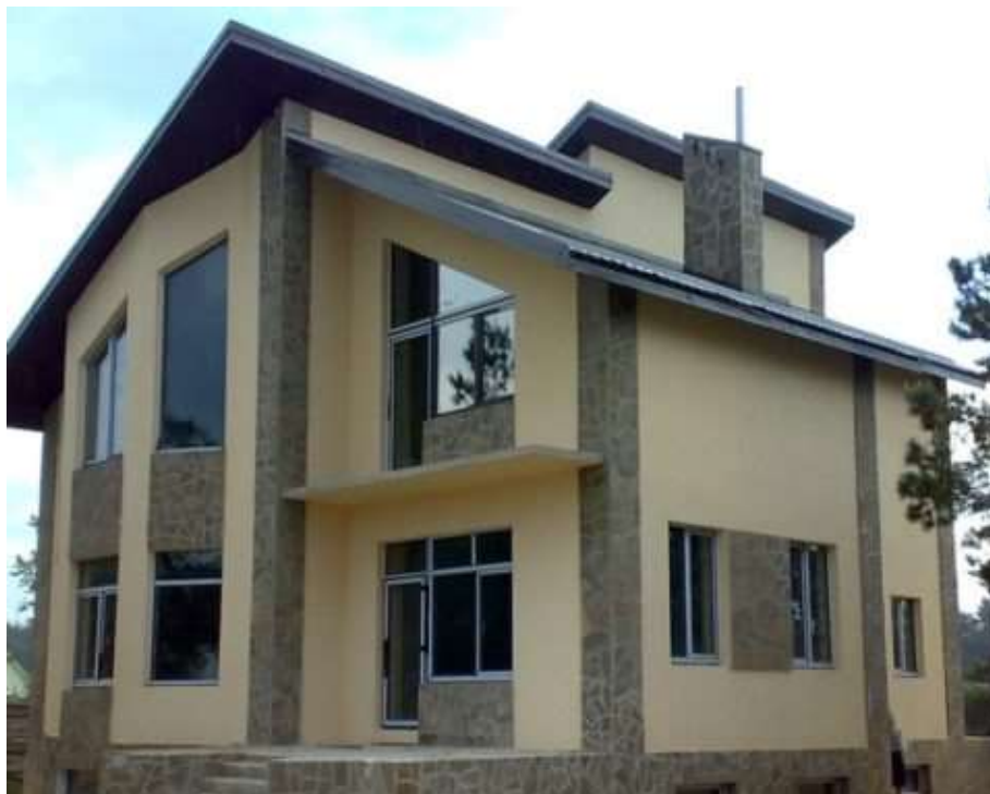
Рис.4. Здание жилого дома, построенное из рядовых мелких стеновых блоков с отделкой [1].
