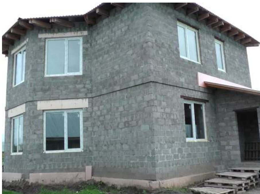
Рис.3. Жилой дом, возведенный из рядовых стеновых блоков без отделки внешней поверхности стен [1].
