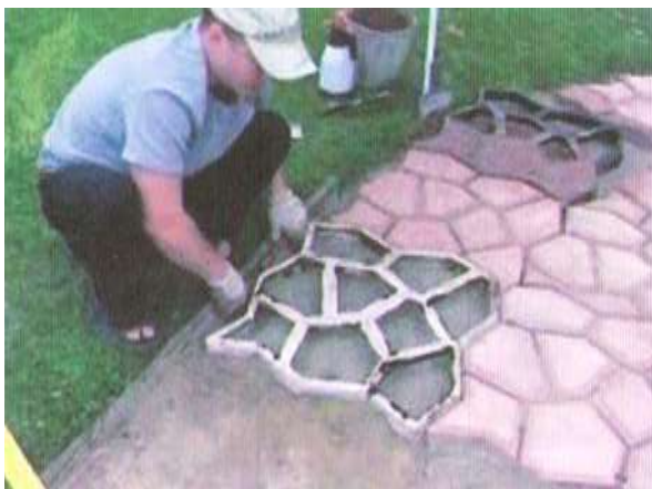
6.5-расм. Мозайкали плиталарни жойнинг ўзида тайёрлаш.
