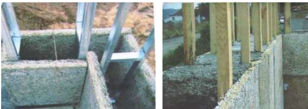
5.10-расм. Фибролит плиталар билан қопланган ташқи деворлар. а-фибролит плиталарни деворга ўрнати. б-ораси енгил бетон билан тўлдирилган фибролит-синчли девор
