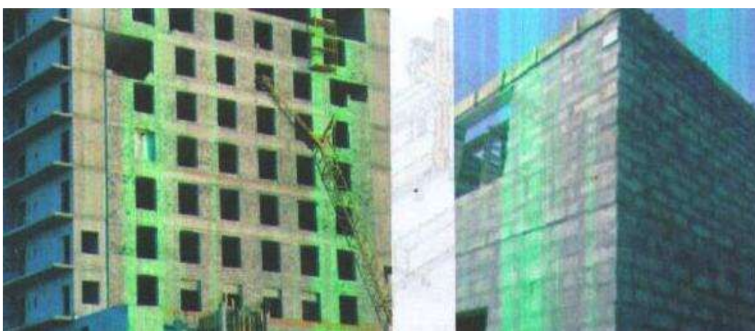
2.11-расм. Кўпикбетон буюмлар (а) ва улардан барпо этилган бинолар(б).
