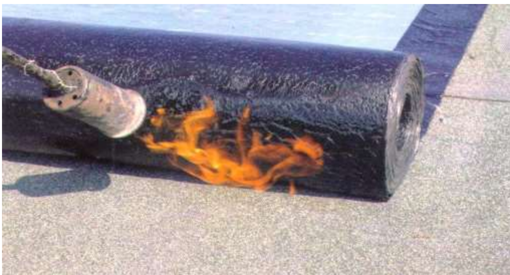
7.5-расм. Фольгоизолни том қопламасига эритиб ёпиштириш
