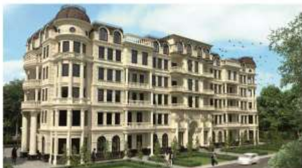
Фасад жилого дома по ул. Алшера Навои, в г. Самарканде.
