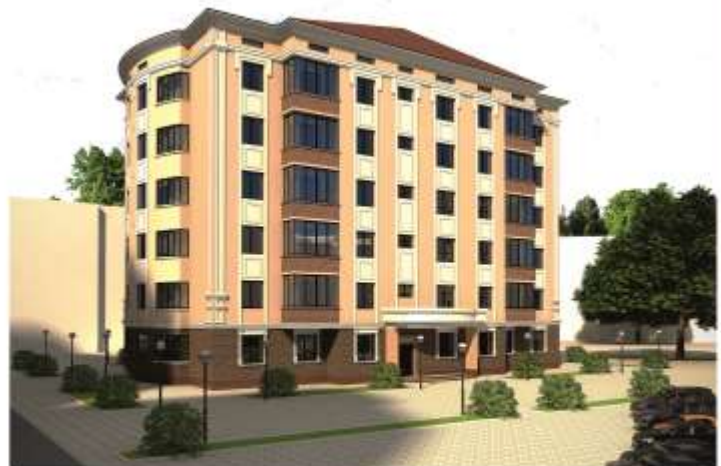
Общий вид фасада.
