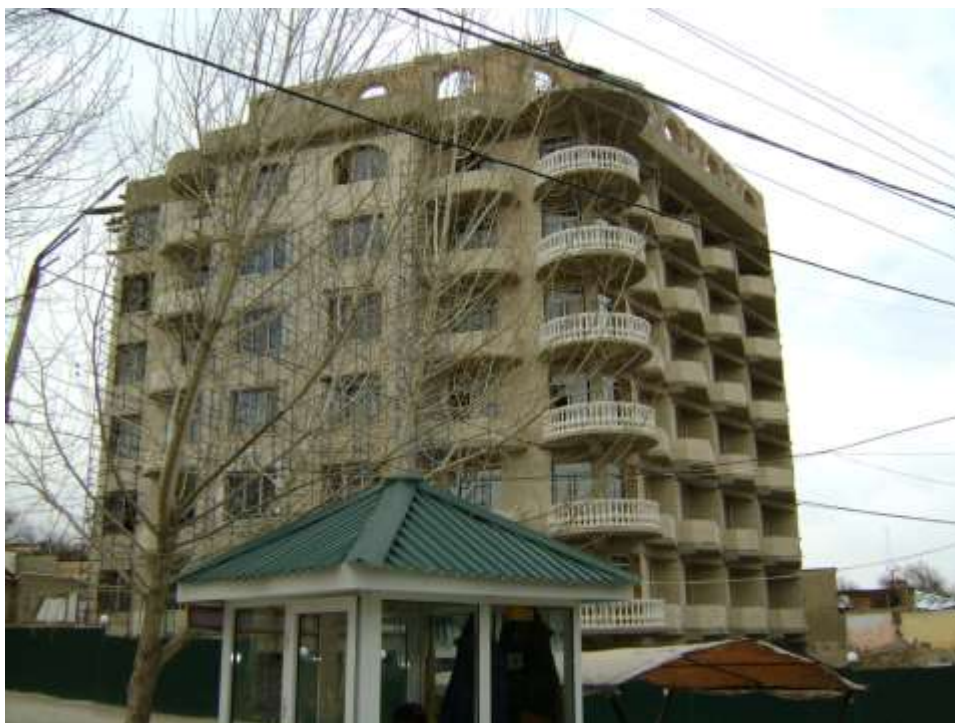
Фото.3.2.3. Вид на фасад здания. Жилой дом по ул. Мироншоҳ Мирзо в г. Самарканде.
