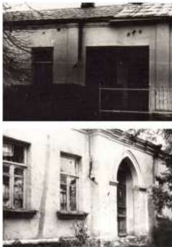
Фасады из обожженного кирпича; кирпич-сырец используется в конструкциях стен по периметру.
