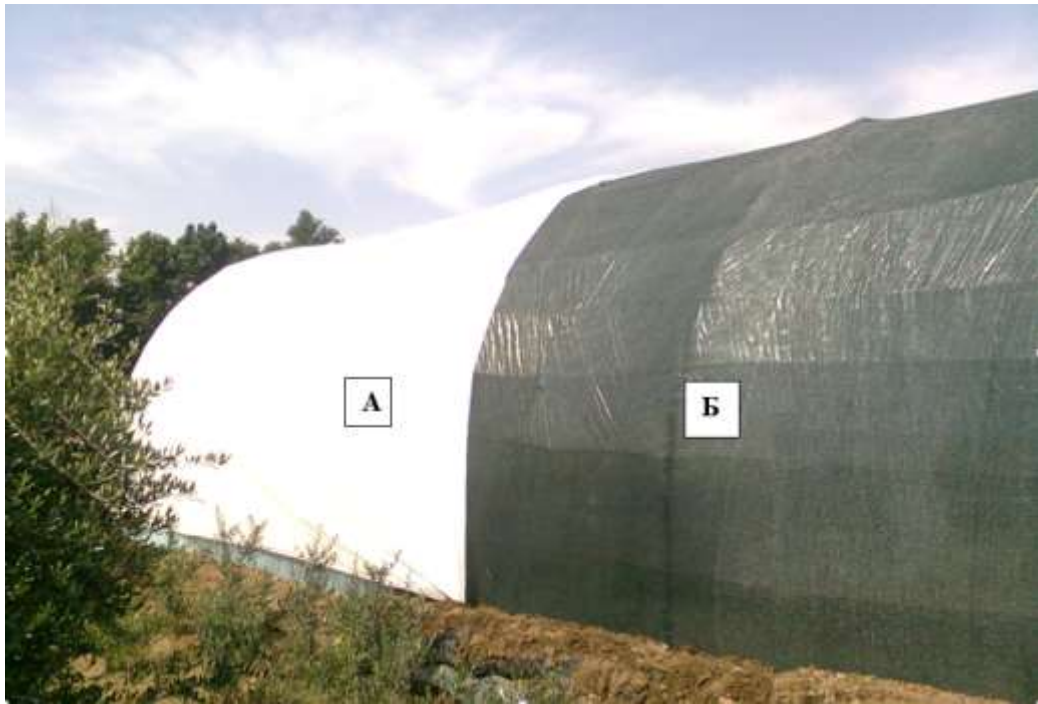
3-расм. Зайтун кўчатларини етиштиришда фойдаланиладиган махсус микроиқлими бошқариладиган иншоот. (А-қўшимча оқ бўз мато билан ёпилган, Б-қўшимча боғ сеткаси билан ёпилган)
